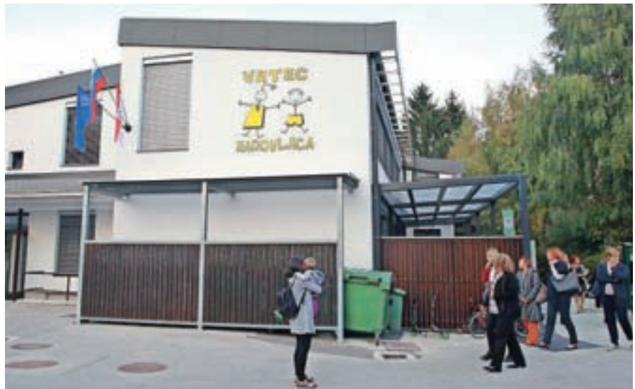
Jeseni je bila zaključena energetska sanacija radovljiškega vrtca.
